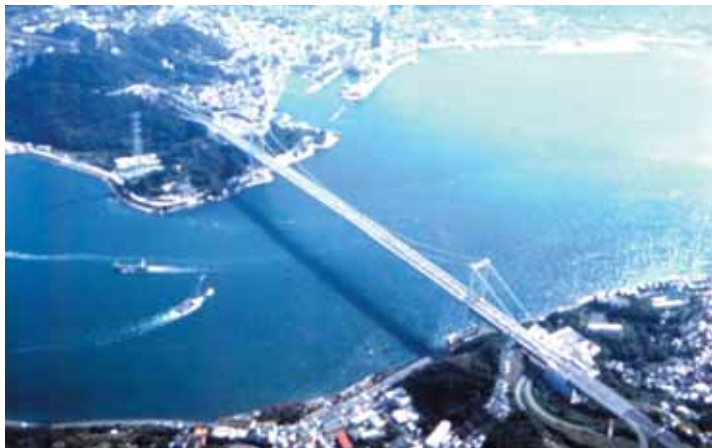
関門橋 橋脚付近が下関・壇ノ浦、対岸は門司・和布刈
