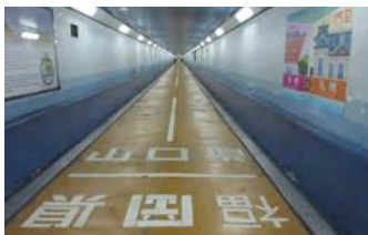
関門国道トンネル(人道)
